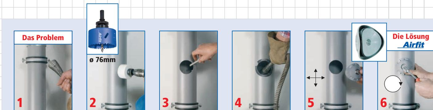
1) ... keine Reinigungsmöglichkeit! 2) Loch bohren Ø 76 mm 3) entgraten 4) Kantenschutzprofil aufstecken, reinigen 5) Rohranbaustopfen aufsetzen 6) Schraube anziehen – FERTIG!
